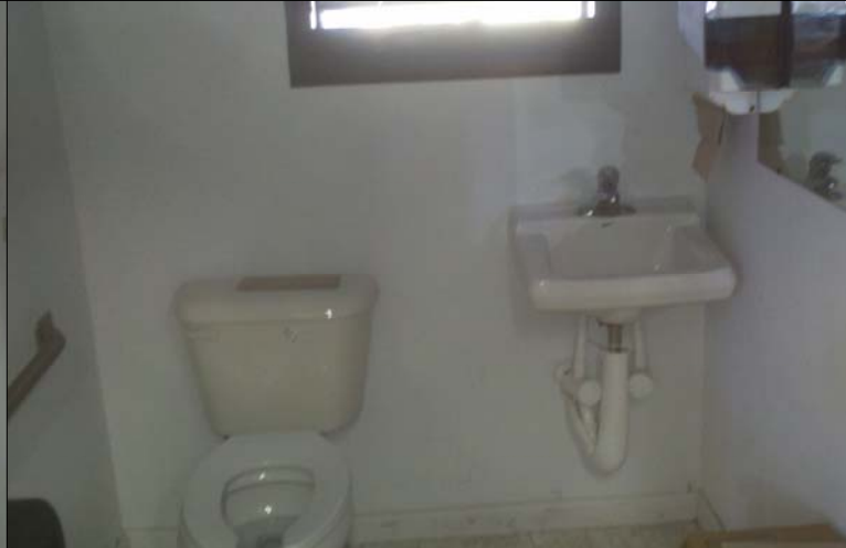
P-6 Existing Toilet
